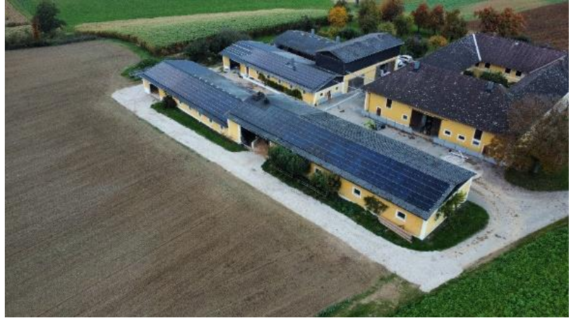
Abbildung 1: PV-Anlage am Betrieb Ziegelbäck
